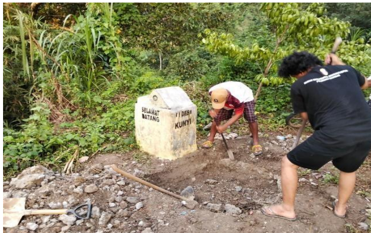
gambar 1. Proses pembuatan pondasi
